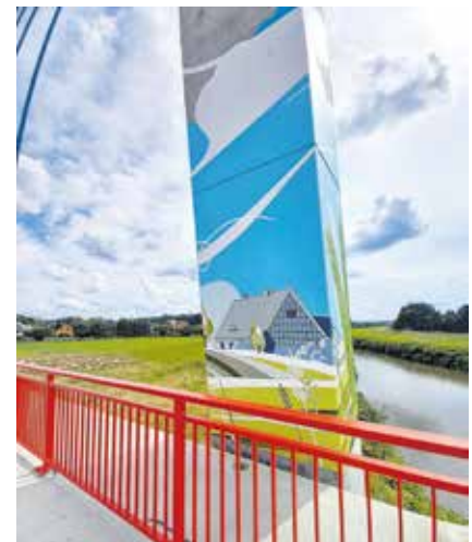
Graffiti an der neuen Brücke in Schlunzig Foto: Landratsamt
