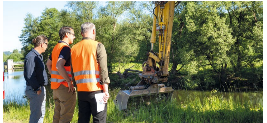
Bürgermeister Denis Grellmann, Beigeordneter Mario Müller und Landrat Carsten Michaelis (v. l. n. r.) begleiten den ersten Baggerhub. Foto: Landratsamt Zwickau
