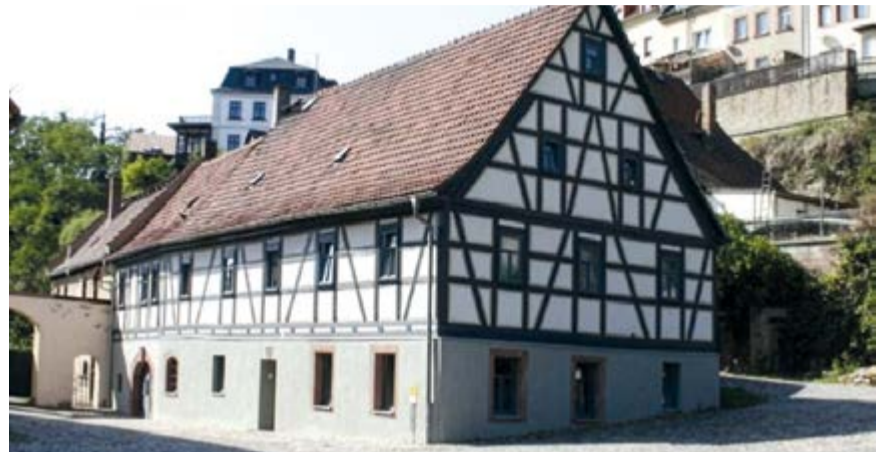
Fachwerkbau in Waldenburg
