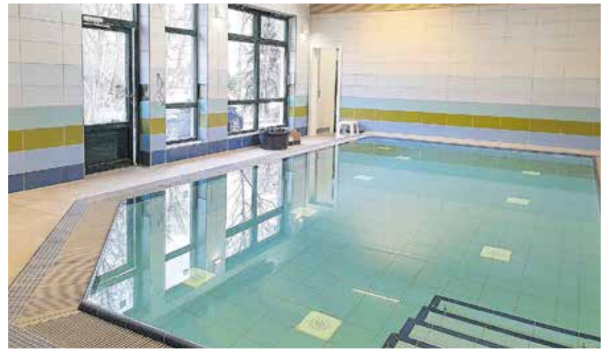
Das neu sanierte Bewegungsbecken in der Sonnenbergschule in Werdau Foto: K. Dinger
